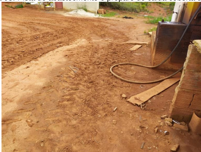
Figura 08: Pista de abastecimento e preparo de calda coberta de lama.
