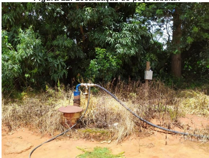
Figura 12: Localização do poço tubular.
