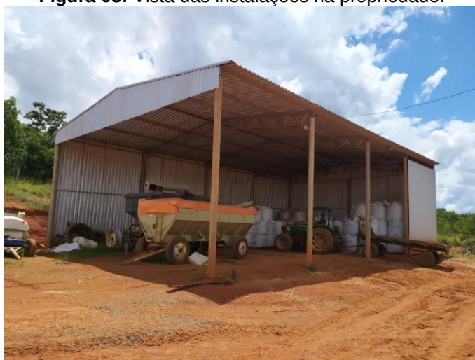
Figura 03: Vista das instalações na propriedade.
