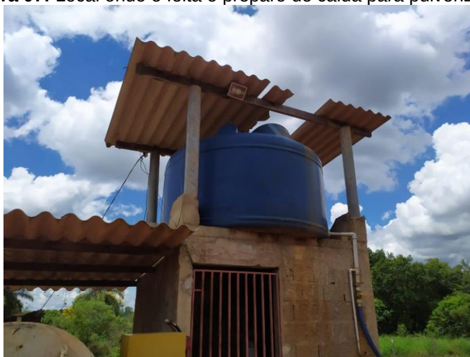
Figura 07: Local onde é feita o preparo de calda para pulverização.
